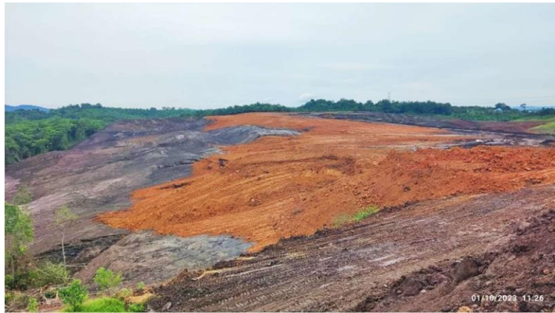
Gambar 3. Proses penutupan disposal dengan menggunakan tanah merah.
