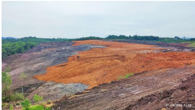
Gambar 3. Proses penutupan disposal dengan menggunakan tanah merah.
