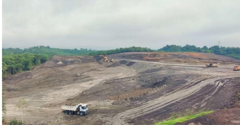
Gambar 2. Proses penataan disposal yang akan dilakukan reklamasi.
