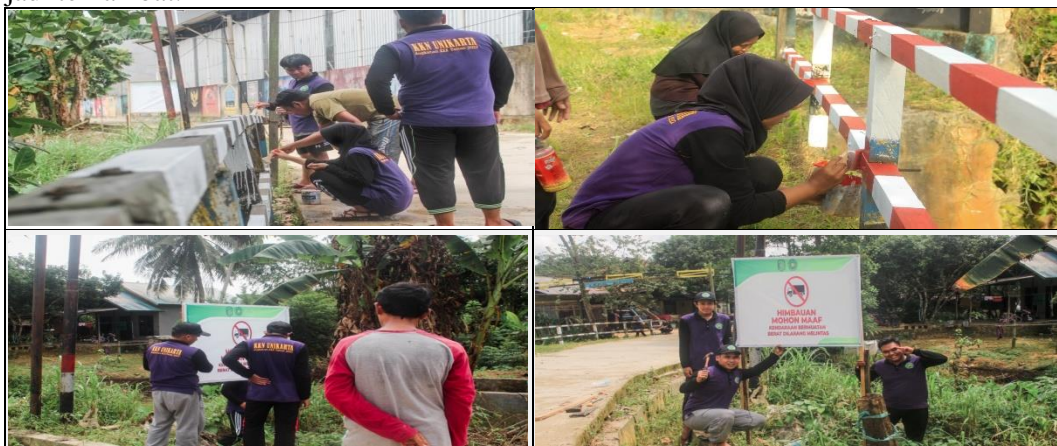
Gambar 6 Perbaikan Jembatan (Pengecatan)
