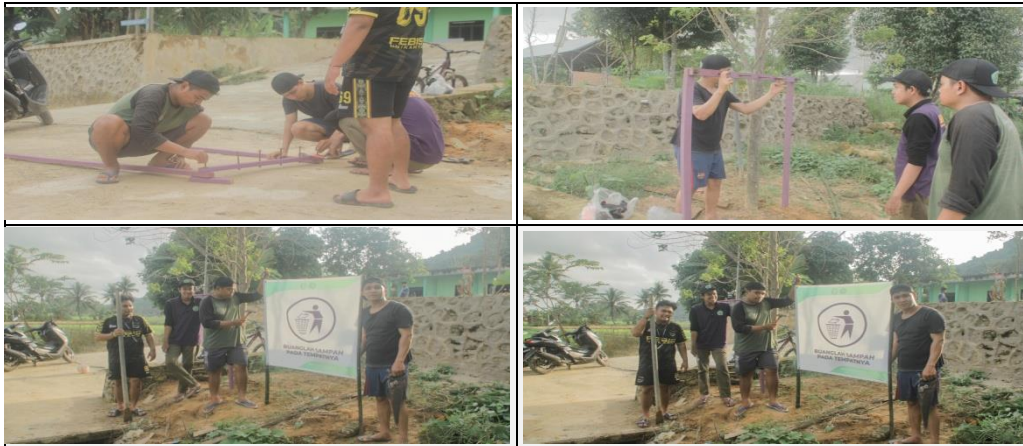
Gambar 9 Perbaikan BAK Sampah
