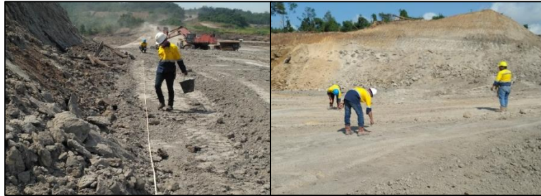
Gambar 4.16 Pemasangan titik bor
