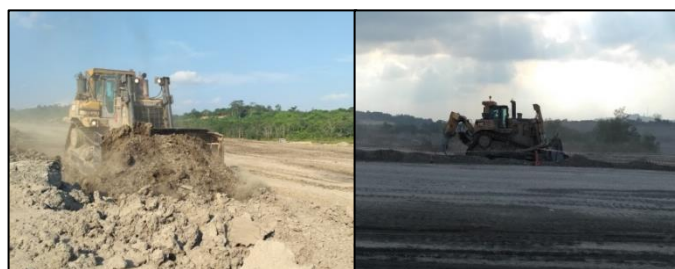
Gambar 4.15 Preparation menggunakan Bulldozer
