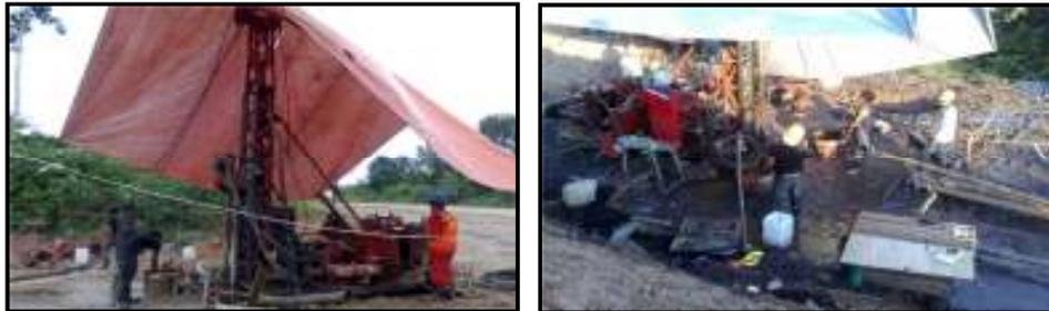
Gambar 2. Kegiatan pemboran Geotek menggunakan jacro 300,
